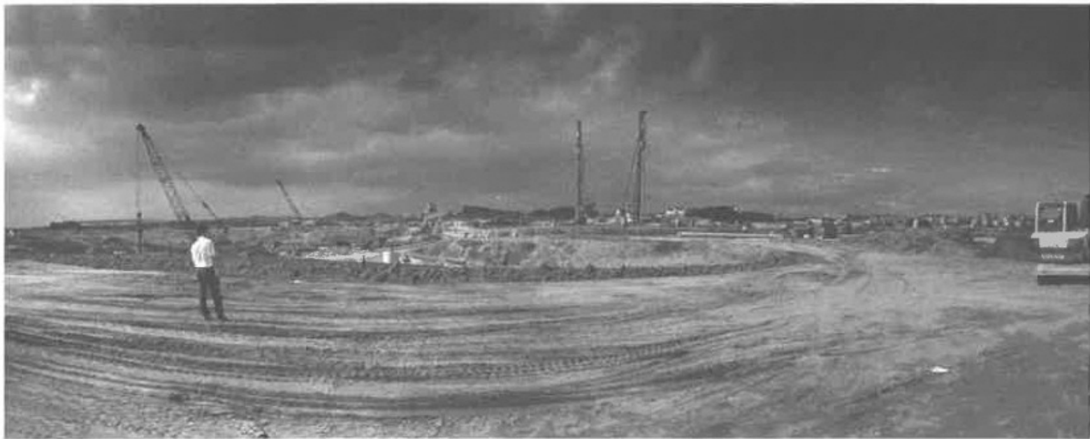
2단계 기반시설공사 현장. 2010. 7.
