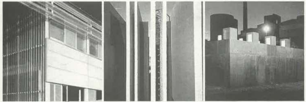
공장생산 콘크리트 판, 유색편을 제작할 수도 있음, 조합을 권장하는 재료 : 유리, 목재, 내후성 강판
