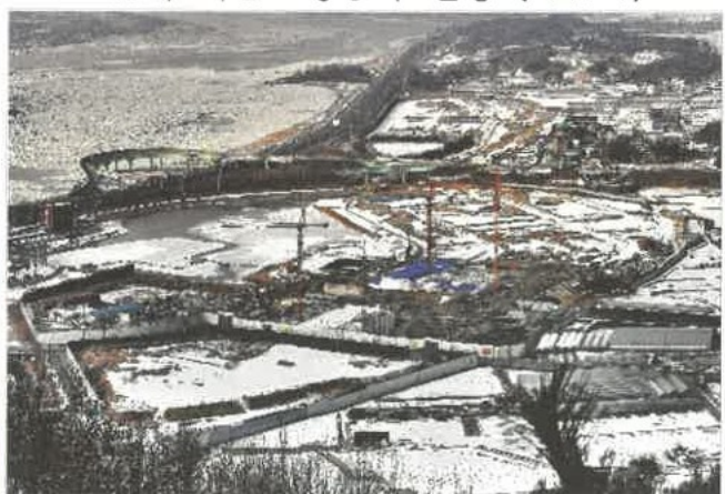
<2단계 기반조성공사 현장 ('11. 1)>
